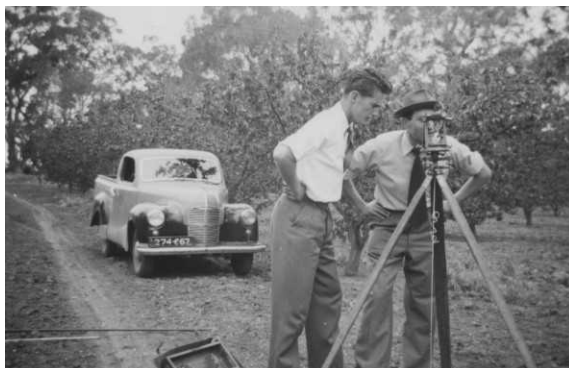
Wytyczamy linie wysokiego napięcia
