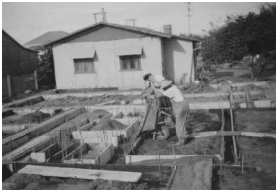
Zakładamy fundamenty stałego domu
