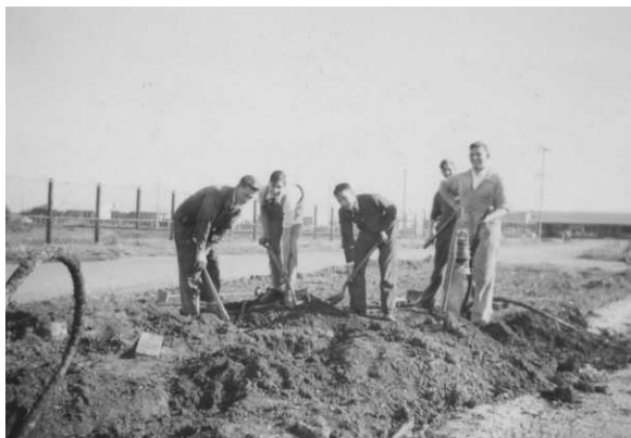
Wykopujemy stare kable elektryczne
